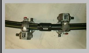
Manchon libre et coulissant . Soudage et refroidissement suivant prescriptions du fabricant de raccord.
